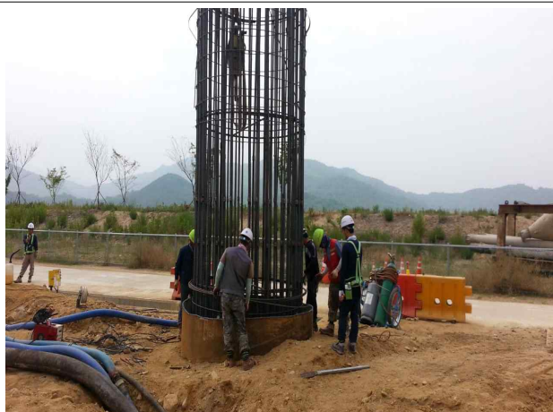
P11 철근망 시공현황(2014.06.08)
