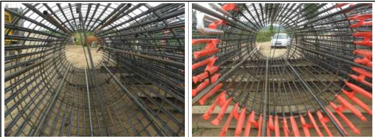
현장타설 말뚝 기초 철근망 보관상태
