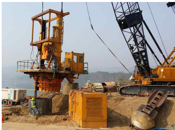
RCD 천공작업 전경
