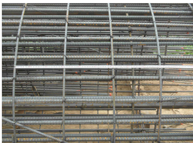
P5 철근망 소성외구간 수평철근 간격측정(C.T.C=300mm)
