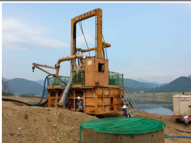
P9 RCD 천공작업 전경(2014.05.20)
